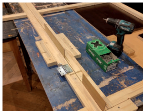
...nach ersten Arbeitsschritten...
